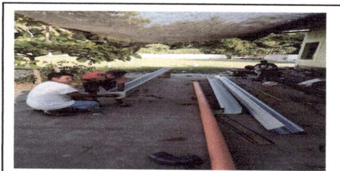
Foto 5: CANALES Y BAJADAS DE AGUA PLUVIALES: Sustitución de canal de aguas pluviales de 2 aulas de PVC 18ML
