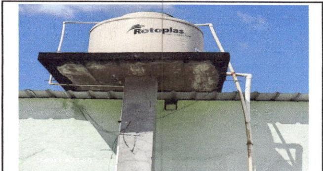
**Foto 8: Mantenimiento de cisterna y depósitos de agua:** sustitución de depósito de agua 1700 lt.
