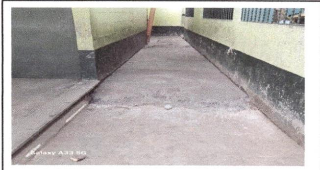
**Foto 7: Losa de patio:** Reparación de plancha de concreto de patio 15m2 módulo 1 de aulas.
